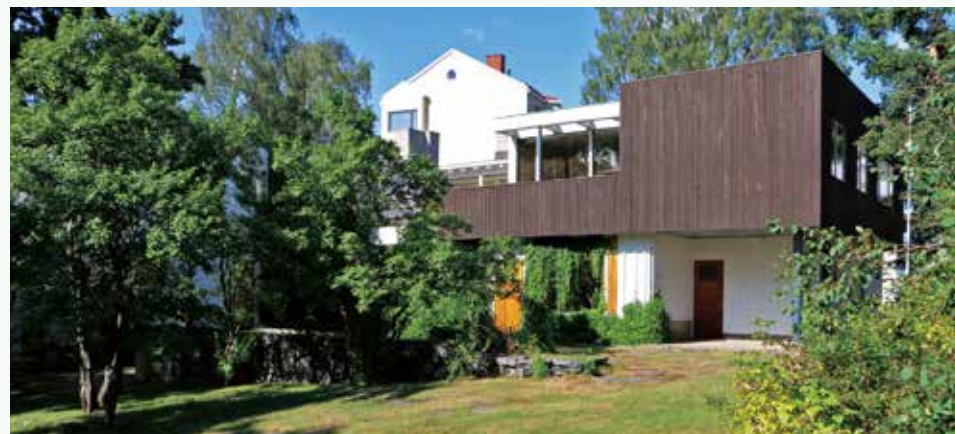
自邸・仕上げを使い分けた庭側外観
