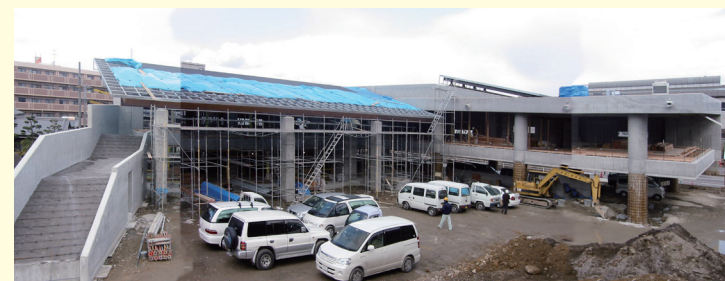
青葉保育園(工事中)
