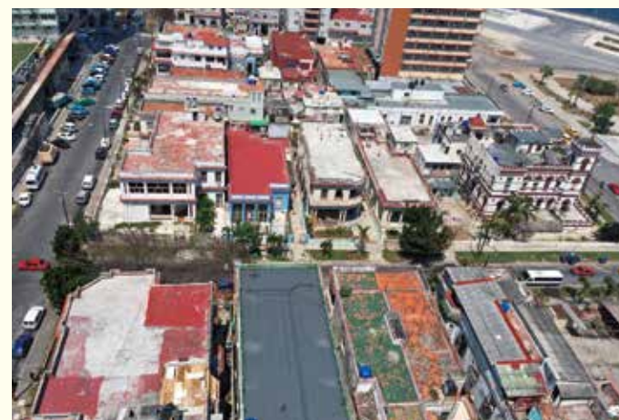
ハバナ市中心街の比較的良質な住宅地。ただし窓ガラスがない。屋根のルーフィングが古くなってはげかかっている。
