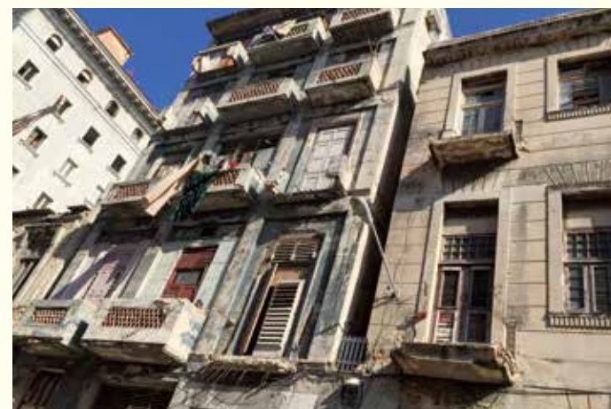
バルコニーの鉄のフェンスは、錆びて完全になくなってしまっている。エレベーターはもちろんない。
