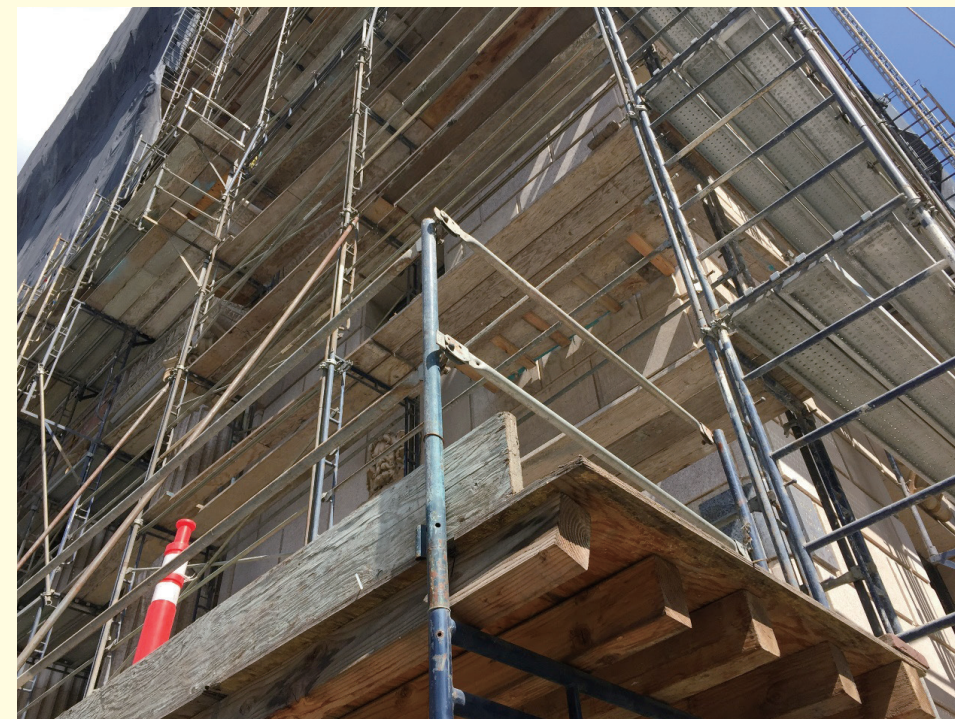
ロサンゼルスで撮影した一部木製の足場
