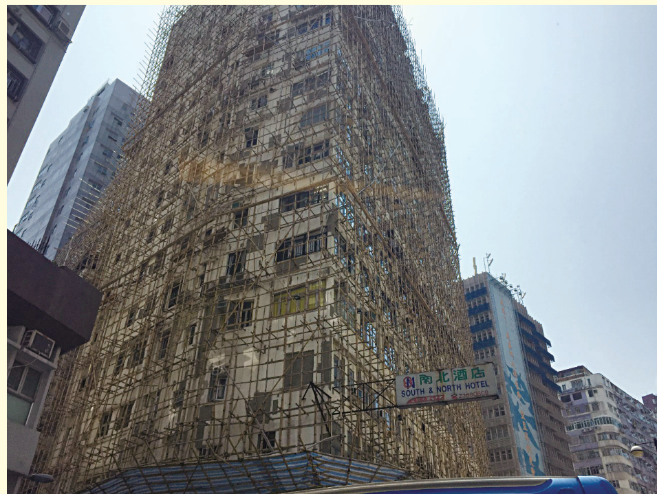
香港で撮影した竹製の足場
