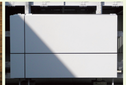
写真・8 モックアップ施工写真
