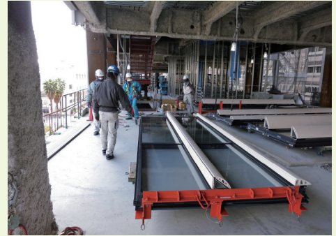
写真・9 吊り治具のセット
