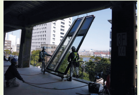
写真・10 カーテンウォールの取り付け
