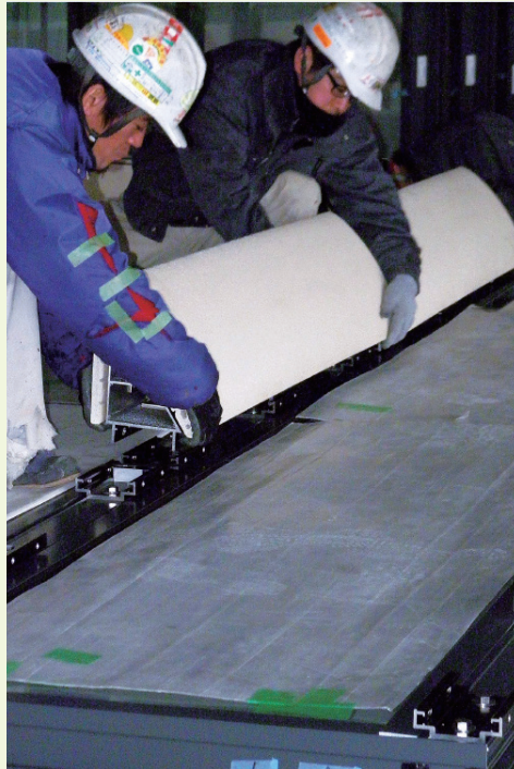
写真・8 テラコッタユニットの組み込み
