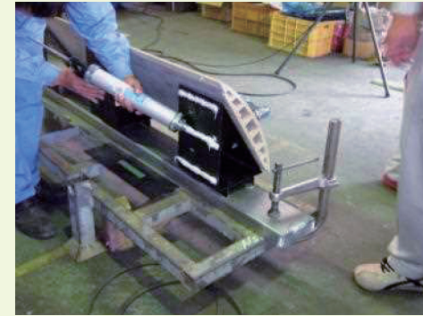
写真・5 弾性接着剤の塗布
