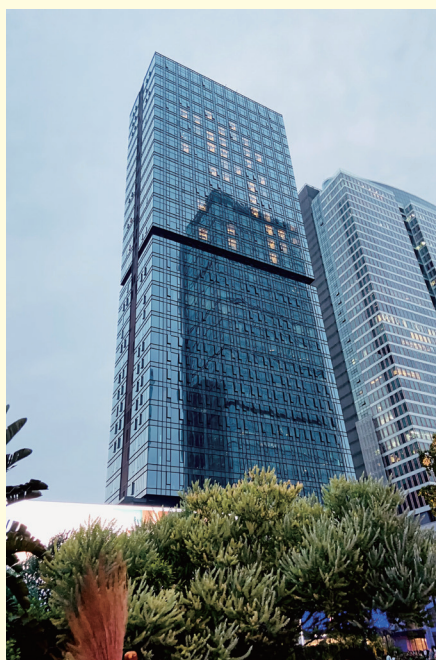
写真1 中国のガラスカーテンウォール建築
