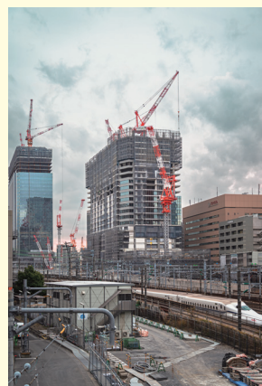
建設中のビルディング
