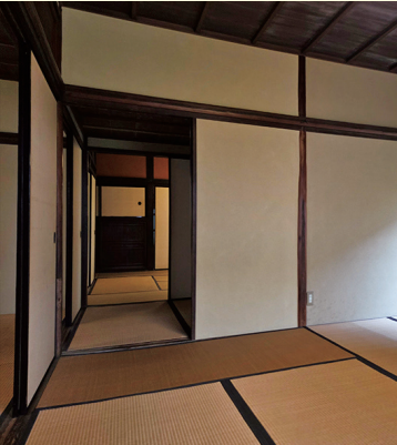
図5 部屋と一体化した経路(福山市 太田家住宅)
